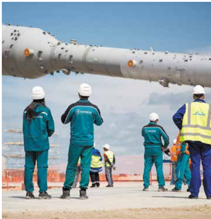
Монтаж крупнотоннажного оборудования на Амурском ГПЗ. 2018 год
