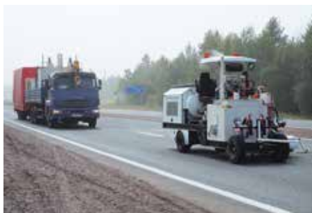
Нанесение разметки термопластиком
