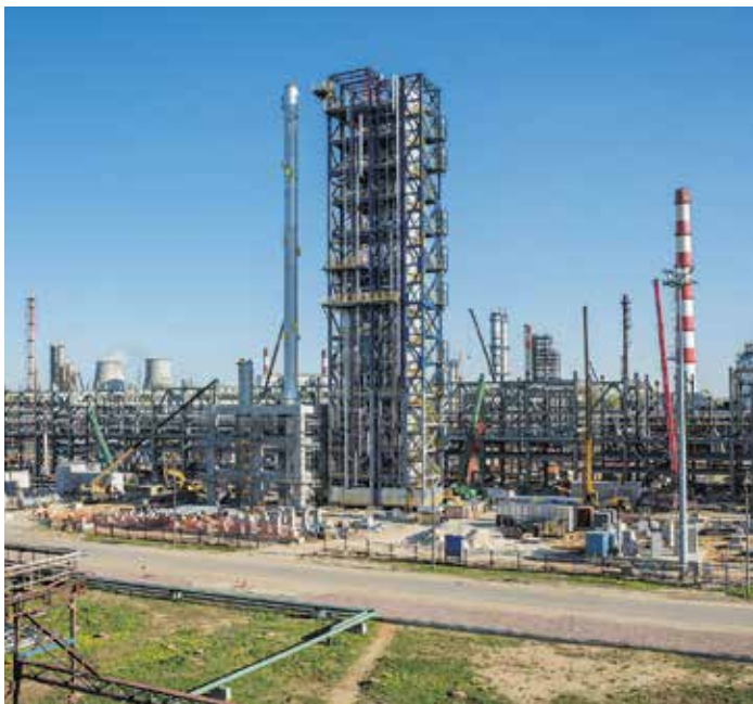
Строительство установки «Евро+» на Московском НПЗ. 2017 год
