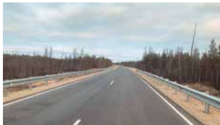
Автодорога А-331 «Вилуй», км 542 + 000 — км 560 + 000, Республика Саха (Якутия). Капитальный ремонт
