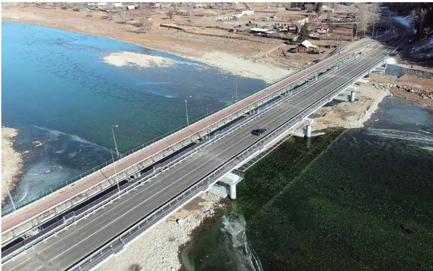
Мост через реку Зун-Мурэн. 65 км автодороги А-333 Култук — Монды — граница с Монголией
